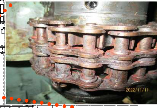
1-1系ばっ気機 (拡大) 動力伝達器交換
