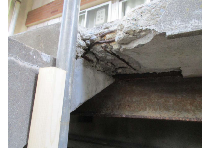
⑦床版欠損・露筋
