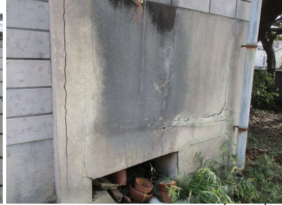
⑥床版亀裂・鉄骨錆
