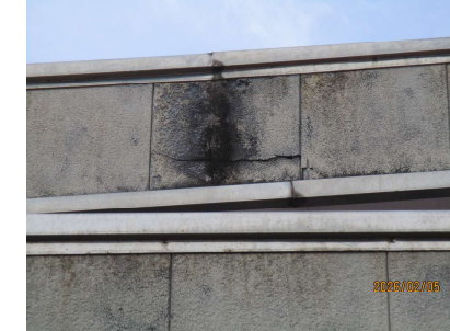
⑫外装仕上げ欠損
