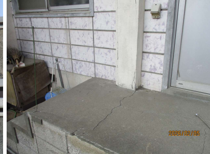
⑬柱亀裂・床亀裂
