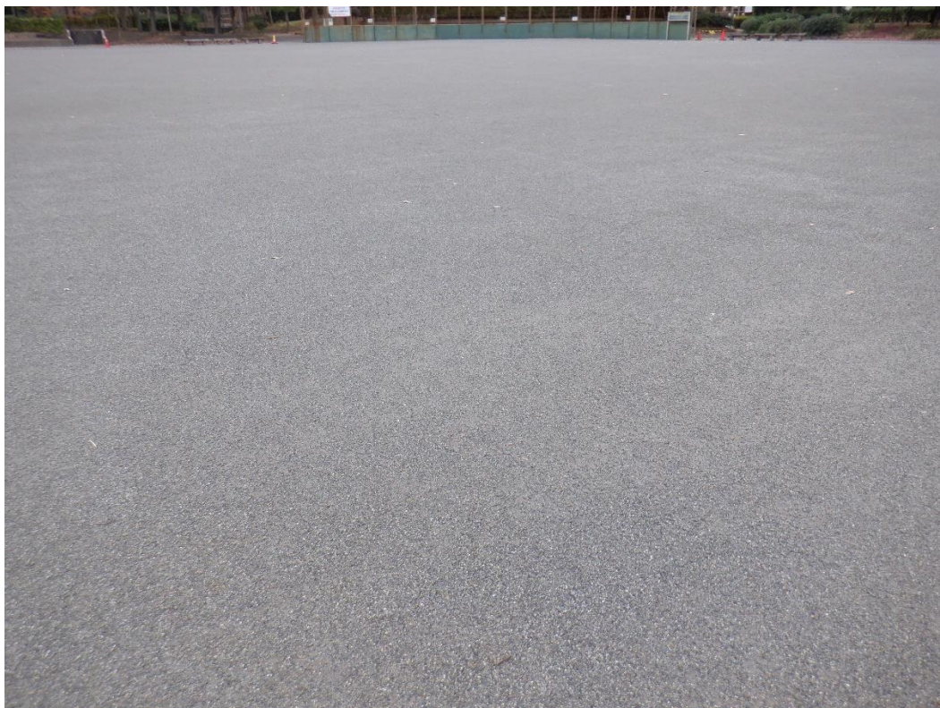
60 原状復旧状況（多目的グラウンド）【令和4年12月1日（木）撮影】
