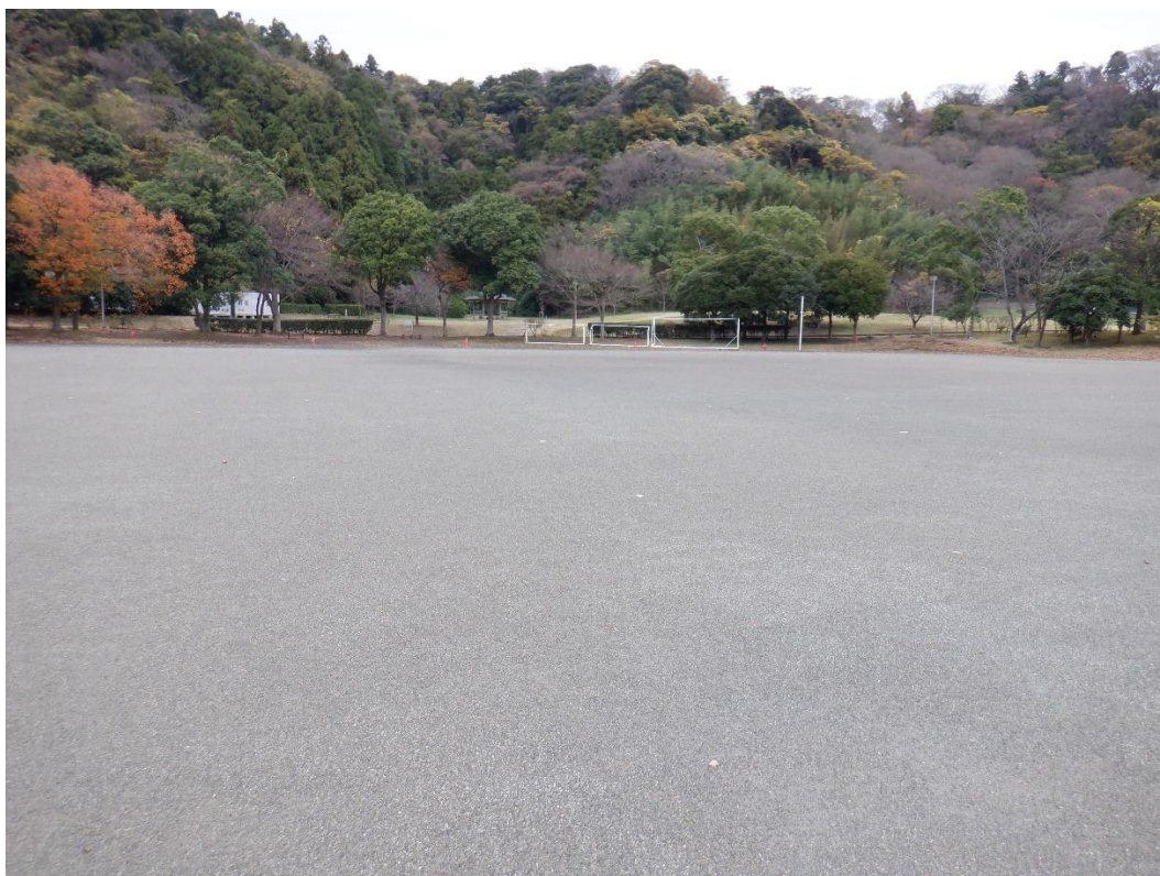
59 原状復旧状況（多目的グラウンド）【令和4年12月1日（木）撮影】
