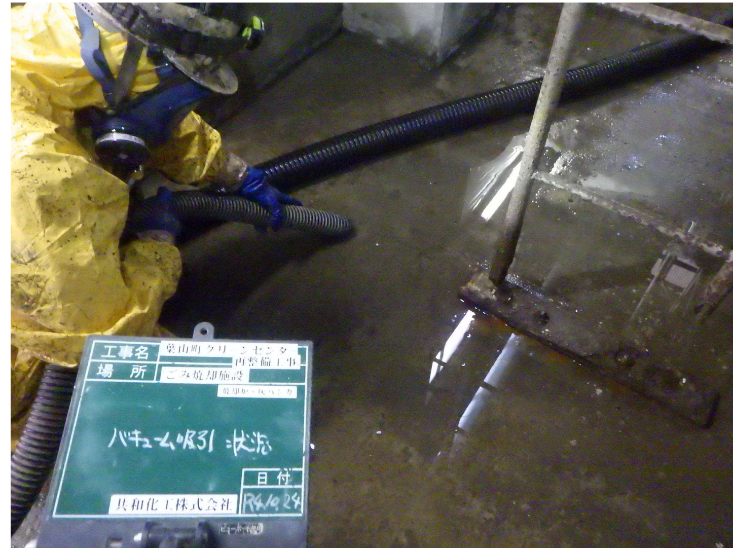
除染水のバキューム吸引
