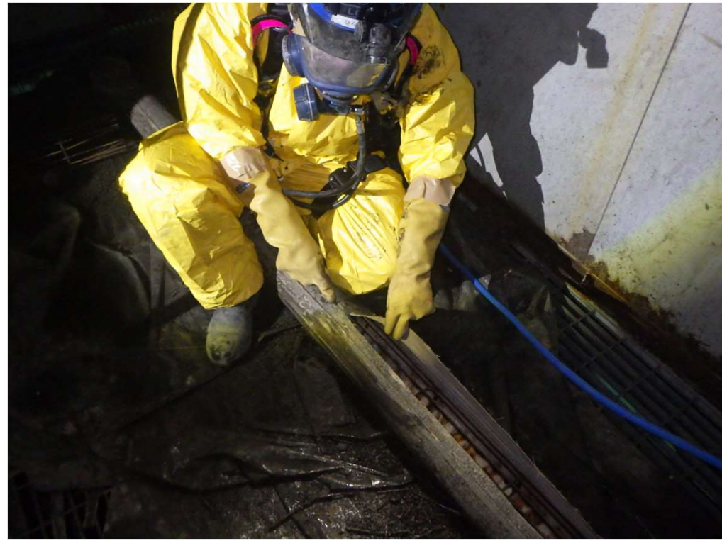
バグフィルター灰出し作業状況
