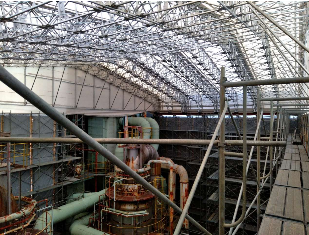
テント内部設置状況
