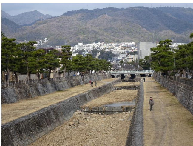
公光橋から見た芦屋川特別景観地区
