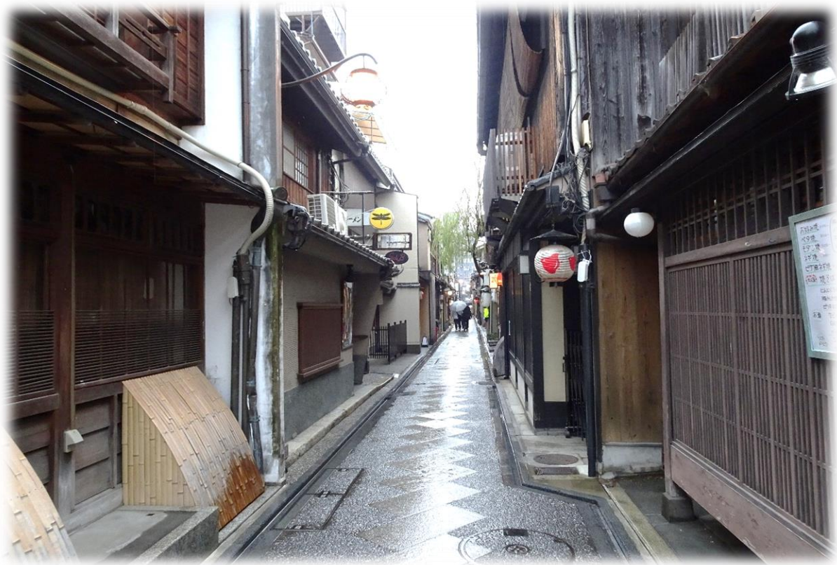
電柱のない先斗町通（左下の竹の囲いの中に地上機器が収納されている）
